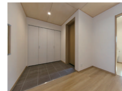
玄関から室内へは、タイルとフローリングに段差をなくすことで車椅子での住み心地が変わります。
