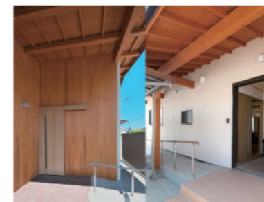
玄関にスロープを設置することで、車椅子だけでなくベビーカーも移動ができるというメリットもあります。
